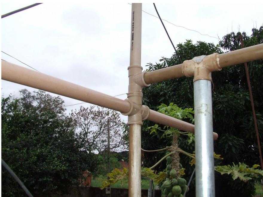
Este “macete” é um segredo até desconhecido por muitos radioamadores. O uso de “t”, curvas e cruzetas em PVC torna fácil não só montar a estrutura de uma antena, mas de fixá-la também num mastro. A foto ao lado dá uma idéia de como fizemos nossa Quadra Cúbica de dois elementos para a faixa de VHF.
